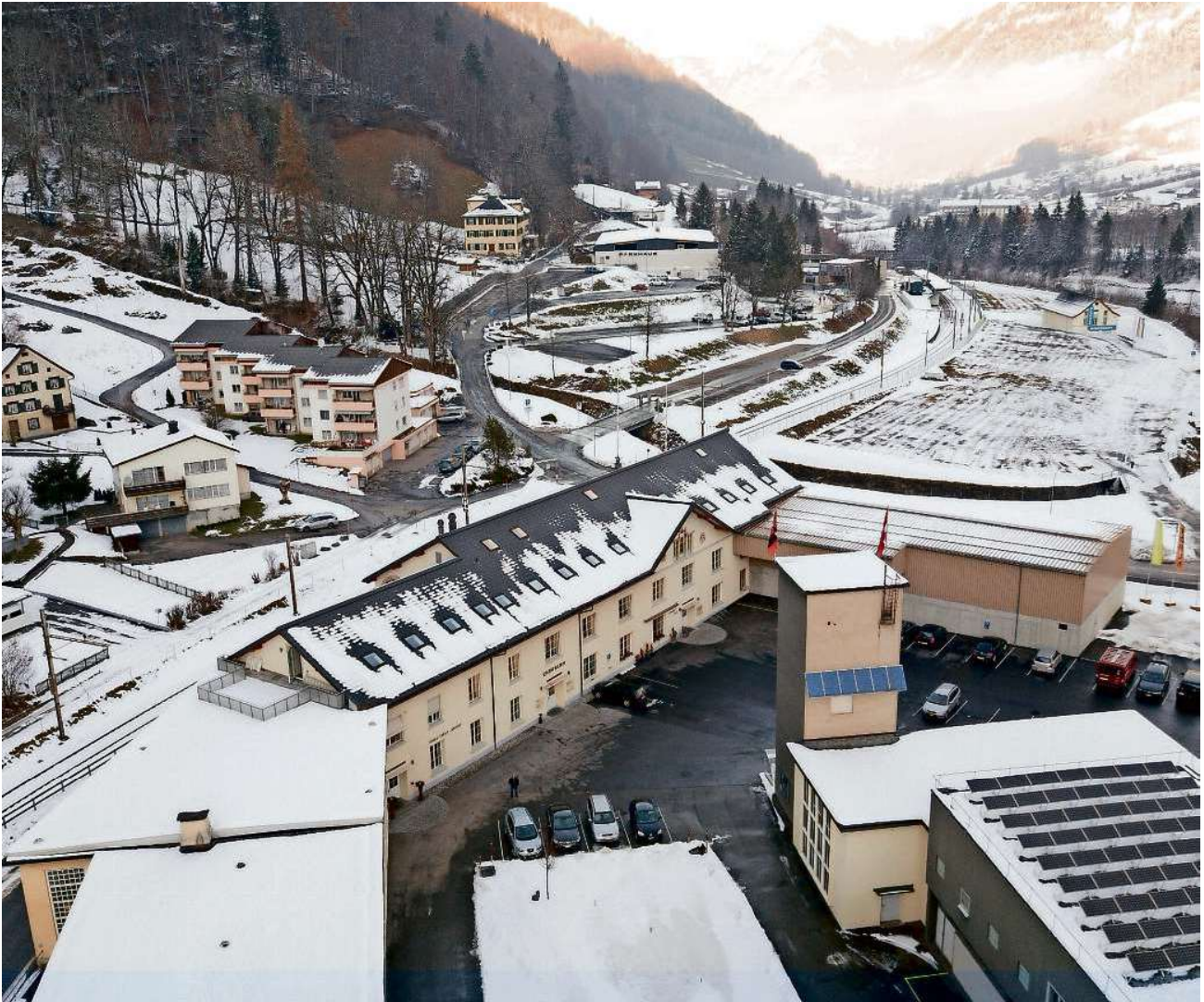
In Gebäudeteilen der ehemaligen Baumwollspinnerei in Linthal entsteht mit Coliving und Coworking ebenfalls ein Start-up. Bild Kanton Glarus / Samuel Trümpy
